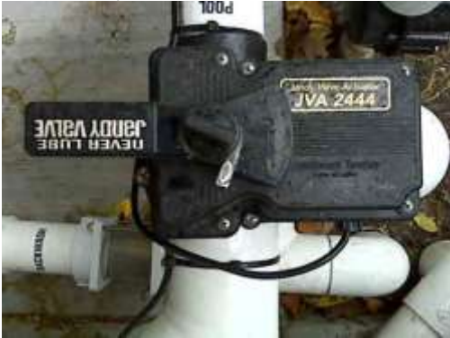
( Fig. 4 ) Jandy JVA 2440 Valve Actuator
